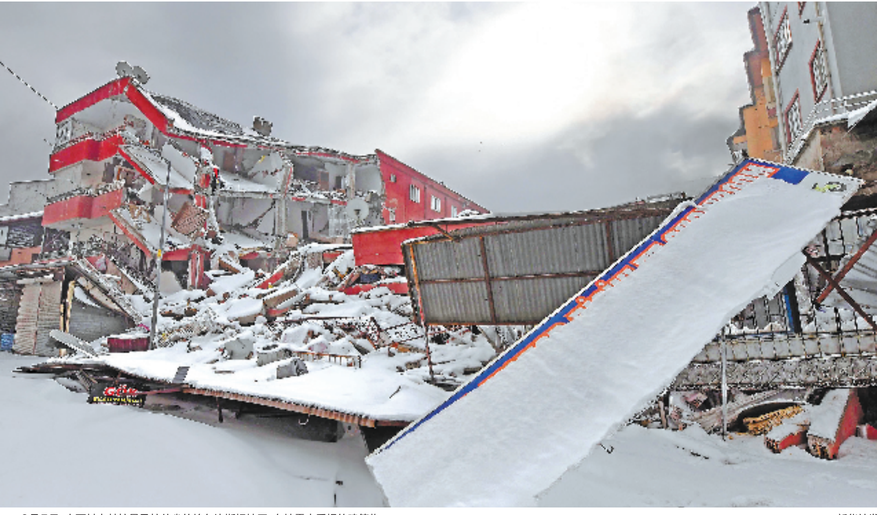
2月7日,土耳其卡赫拉曼马拉什省的埃尔比斯坦地区,在地震中受损的建筑物。
