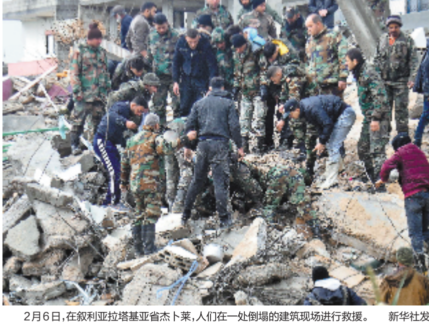
2月6日,在叙利亚拉塔基亚省杰卜莱,人们在一处倒塌的建筑现场进行救援。
