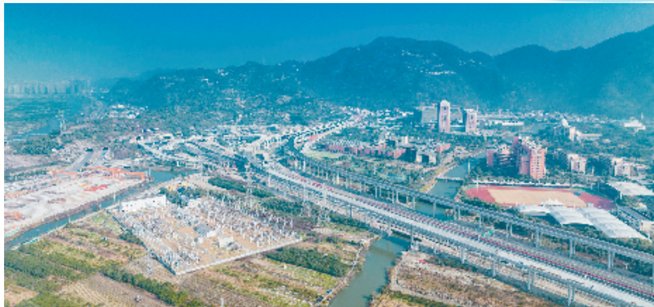
金丽温高速东延线项目俯瞰图
