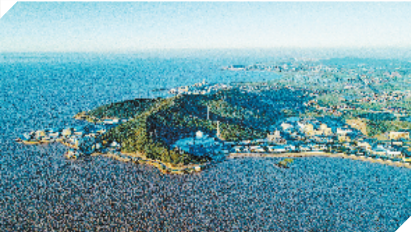
30多年来核工业井巷集团持续扎根核电建设领域(图为秦山核电厂区)
