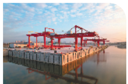
建设中的下沙港
