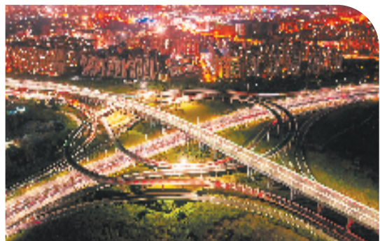
留祥路西延工程
