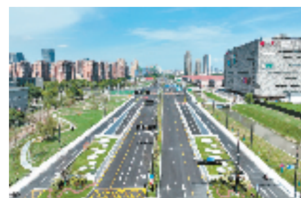
下沙路与12号路提升改造及附属配套工程
