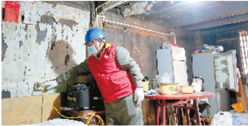
“电力背包客”上门服务 (国网泰顺县供电公司供图)
