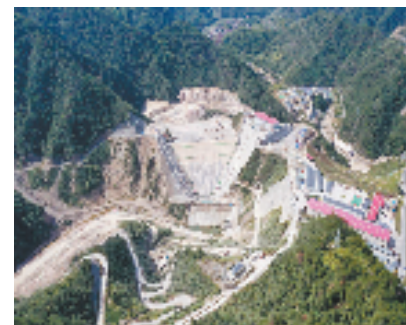
缙云县抽水蓄能电站建设现场
