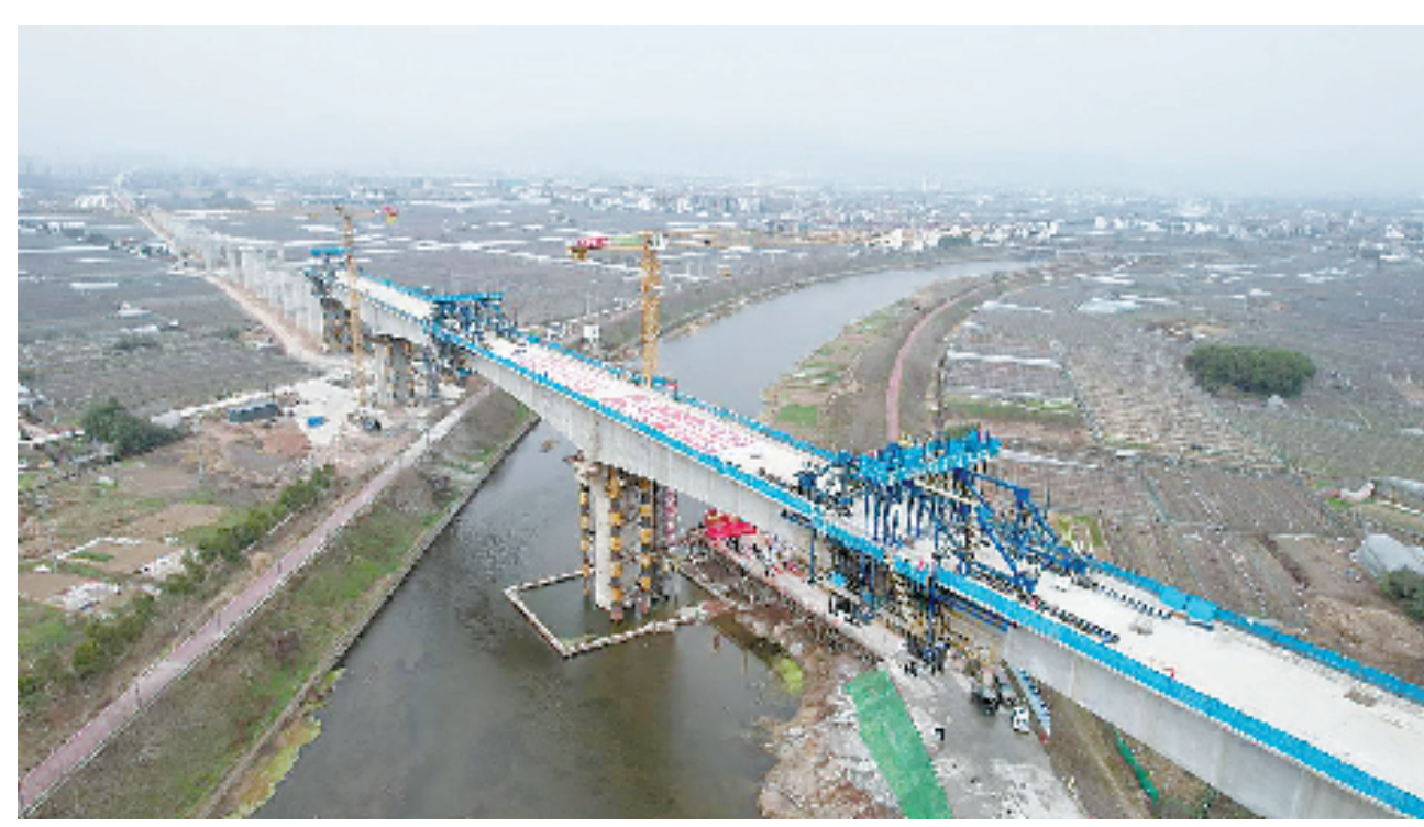
图为杭温铁路二期最大跨度连续梁合龙现场。
