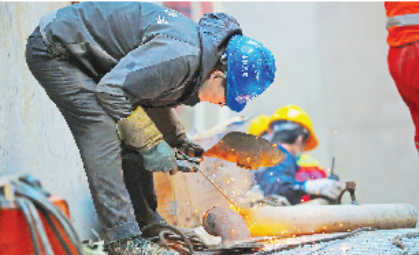
1月4日,在位于德清县武康街道的杭德市域铁路千秋广场站施工现场,工人正在加紧施工。据了解,该铁路全长25.6千米,沿途设9个站。
