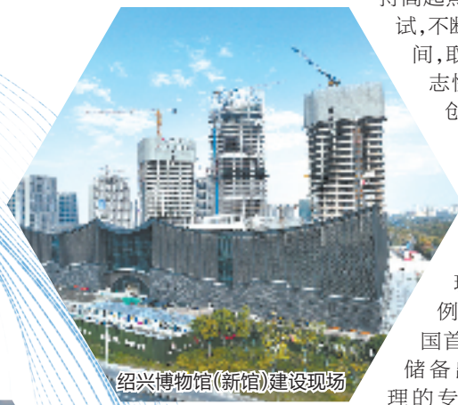
绍兴博物馆(新馆)建设现场
