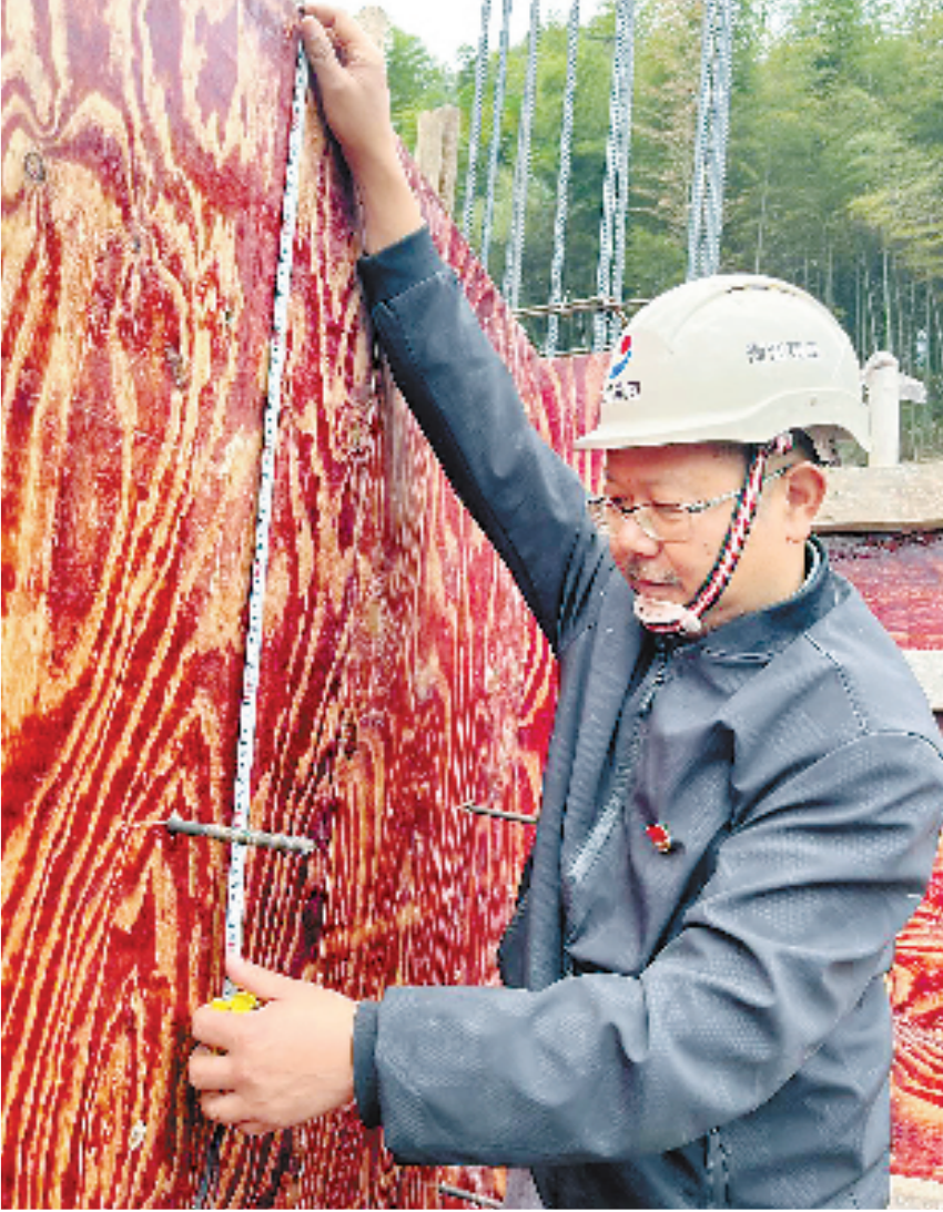
俞锋在工地检查施工进度。受访者供图
