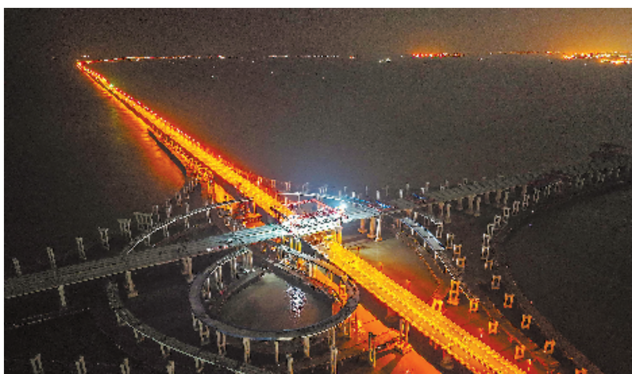
12月27日深夜,在浙江交通集团杭甬复线宁波一期项目滨海互通主线施工现场,架桥机将一片700吨的拼装梁精准平稳地放在甬舟高速金塘大桥两侧的桥墩上,项目建设稳步推进。
