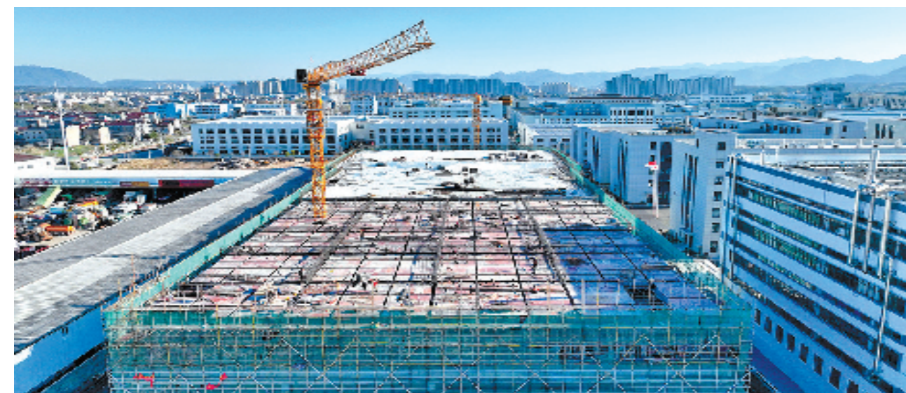
浙江法拉第智控装备有限公司太阳能智能照明灯塔项目施工现场 (图片由天台县白鹤镇提供)
