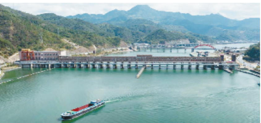
青田船闸建成试通航 汤洪文 摄
