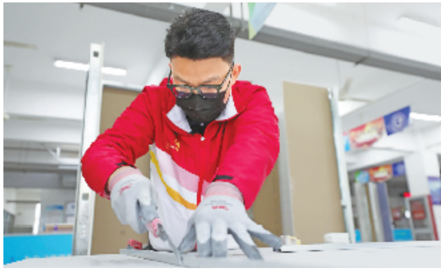
马宏达正在裁切石膏板。
