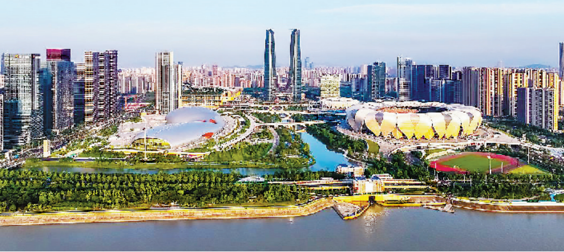
农行浙江省分行全力支持杭州亚运会场馆建设。图为钱江世纪城的“亚运三馆”
