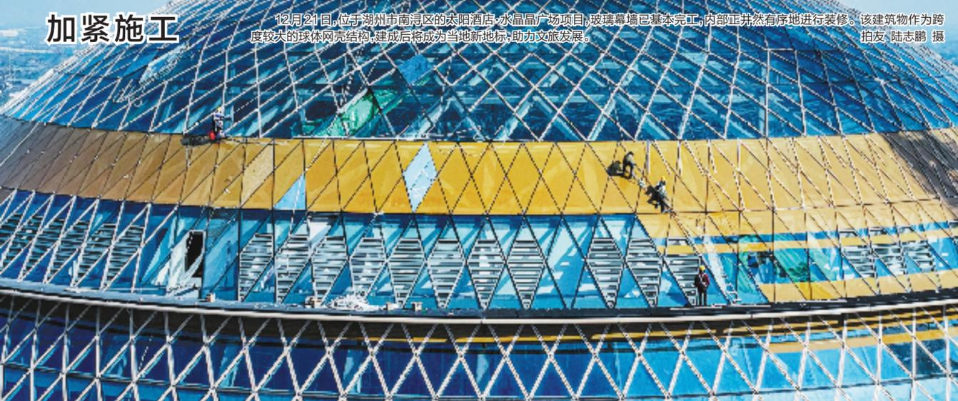
12月21日，位于湖州市南浔区的太阳酒店·水晶晶广场项目，玻璃幕墙已基本完工，内部正井然有序地进行装修。该建筑物作为跨度较大的球体网壳结构，建成后将成为当地新地标，助力文旅发展。 拍友、陆志鹏 摄
