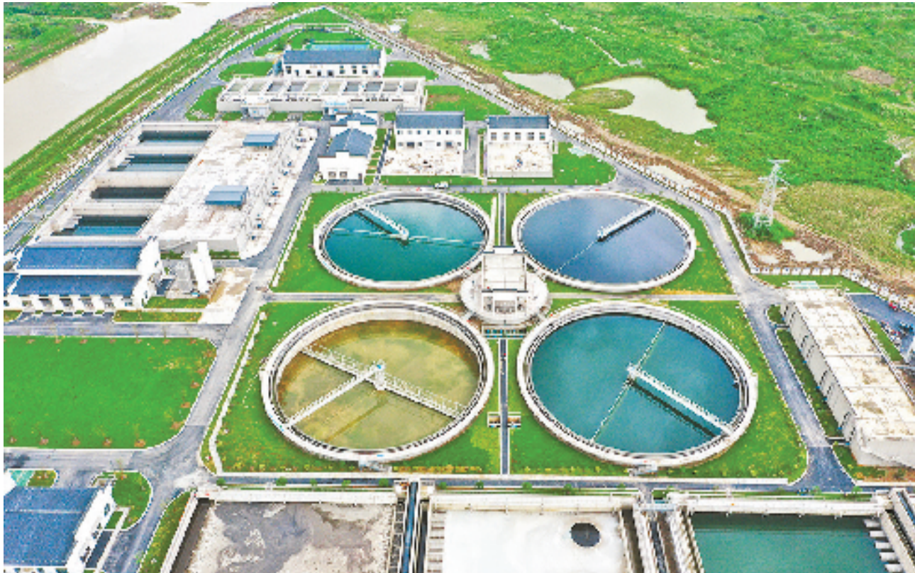
桐乡市城市污水处理厂整合工程(一期)
