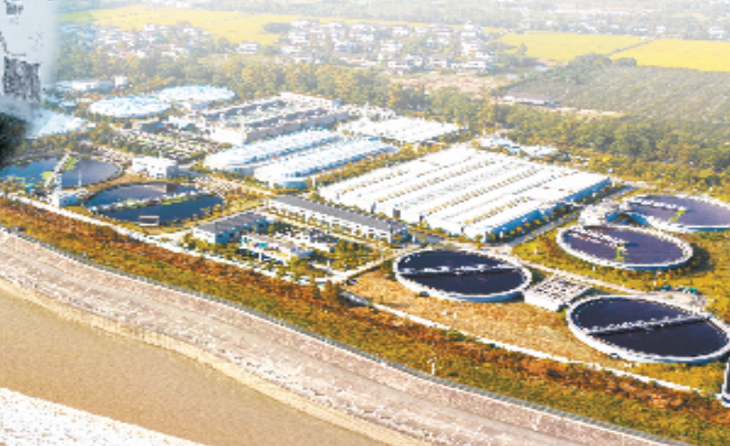
海宁市丁桥镇污水处理厂 海宁市住建局供图
