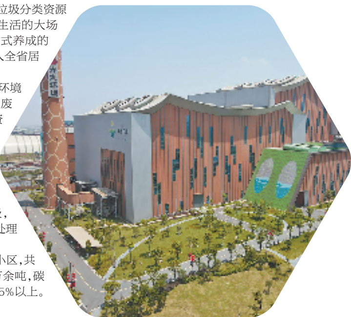
衢州市区生活垃圾焚烧发电项目
