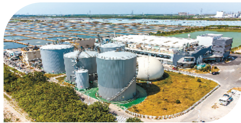
慈溪市开诚厨余(餐厨)垃圾处理厂
