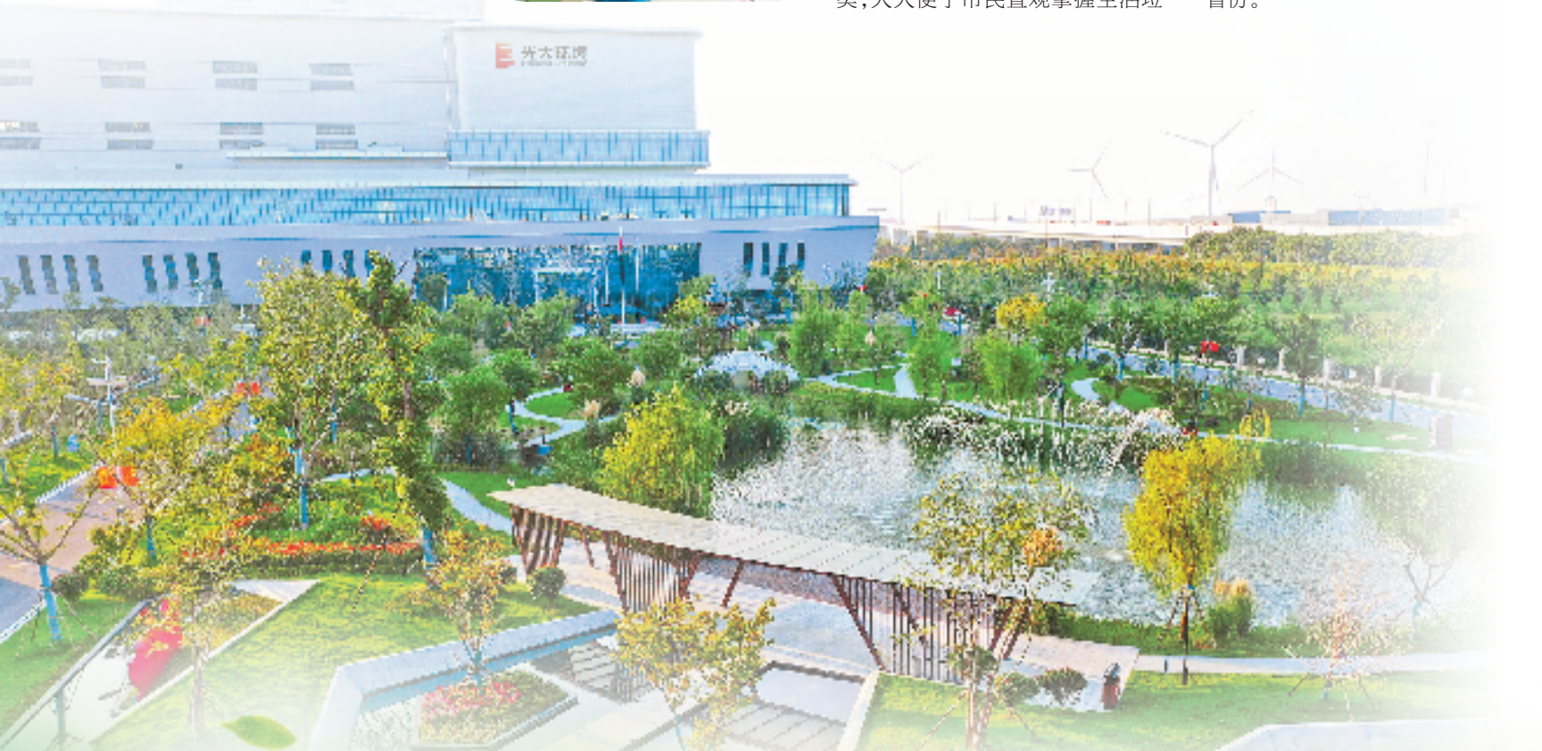
生活垃圾焚烧厂
