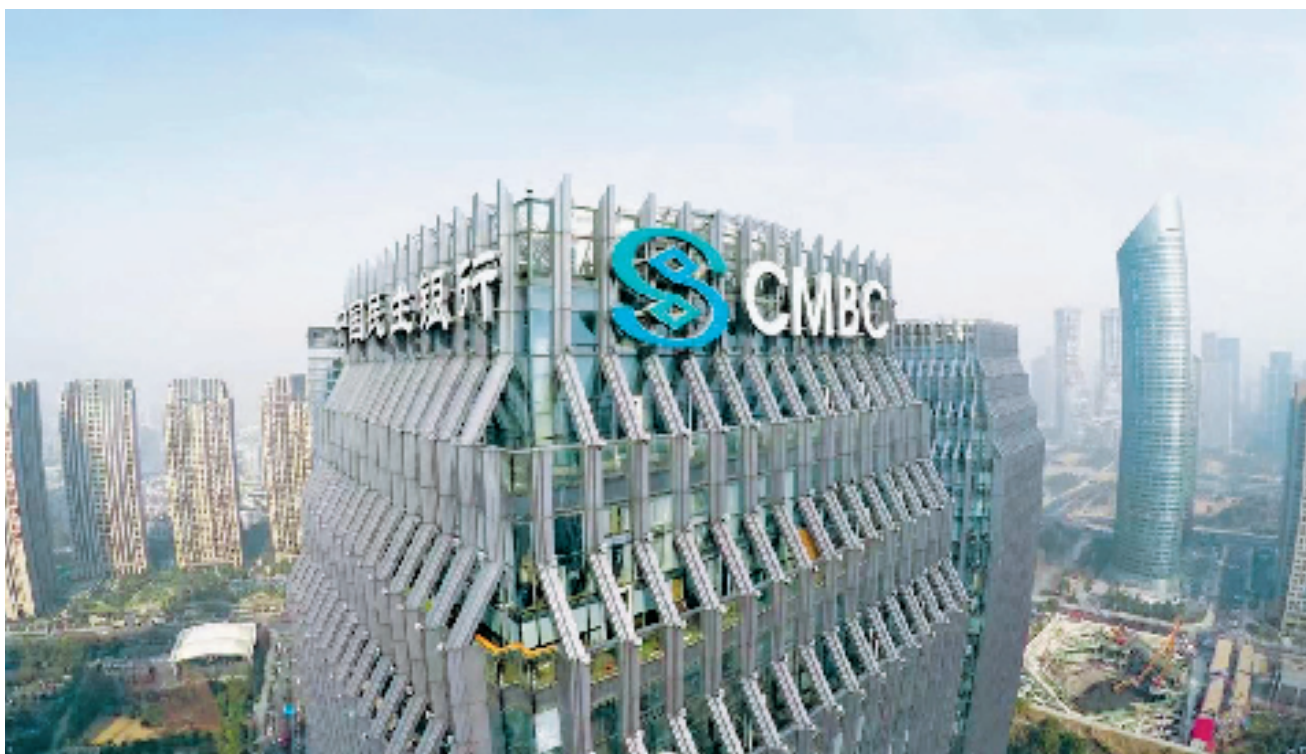
位于杭州钱江新城的中国民生银行杭州分行
