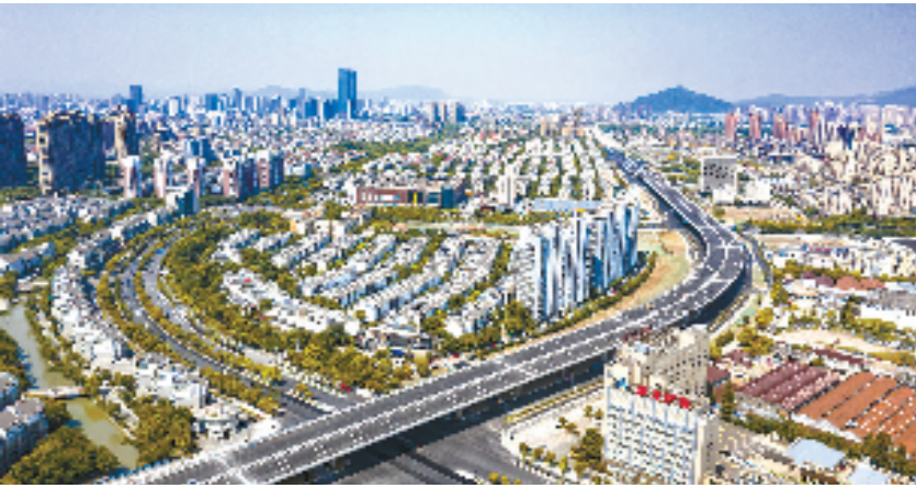
内环(北线)快速化改造项目
