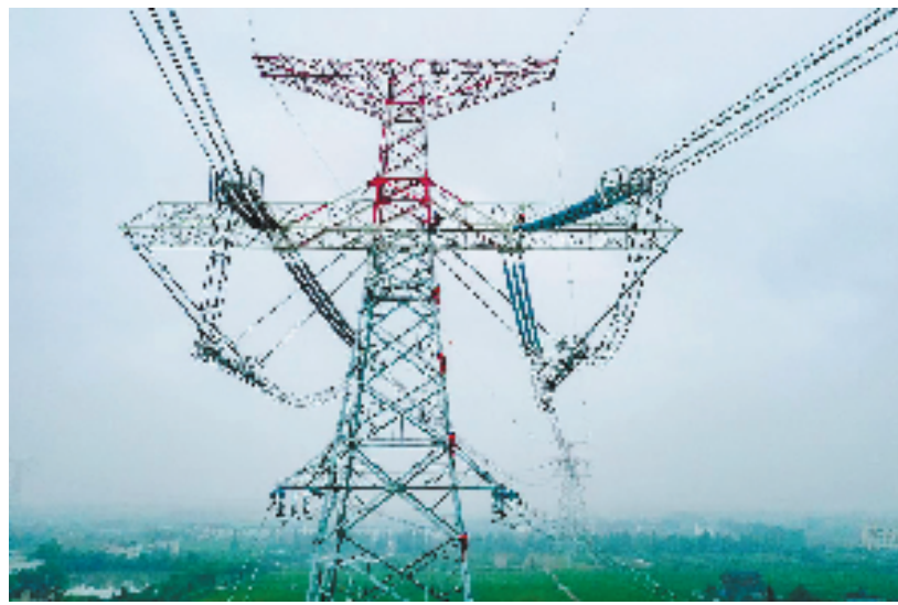
国网浙江电力的工作人员登上白浙特高压工程浙江段线路开展消缺复验。 拍友 张正华 摄
