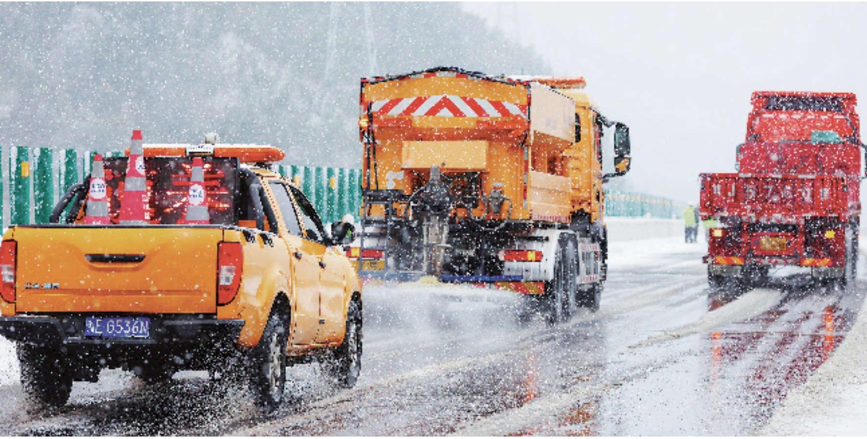
12月1日,湖州市德清县S304上姜湾路段桥梁因大雪出现冰冻现象。德清县公安局交通警察大队莫干山中队的“除冰雪小分队”分工协作,在桥面撒融雪剂,保障群众安全出行。共享联盟·德清 蔡俊 摄
