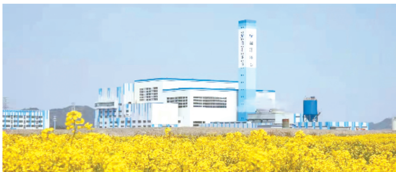
温岭垃圾焚烧发电项目厂区
