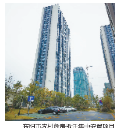
东阳市农村危房拆迁集中安置项目 (图片由金华市住房和城乡建设局提供)
