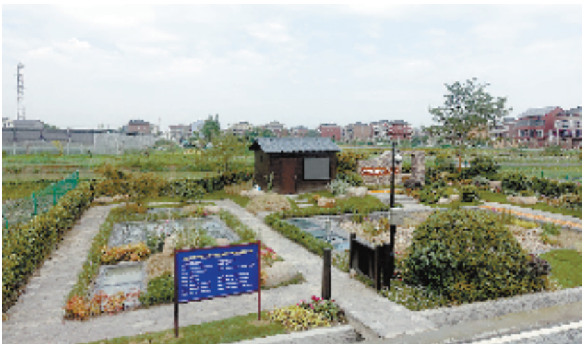
余杭区仁和街道普宁村长桥头农村污水处理设施（杭州余杭水务控股集团供图）
