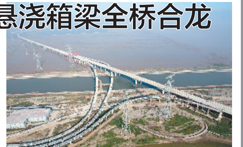
杭甬复线宁波一期澉浦互通 张涛 摄
