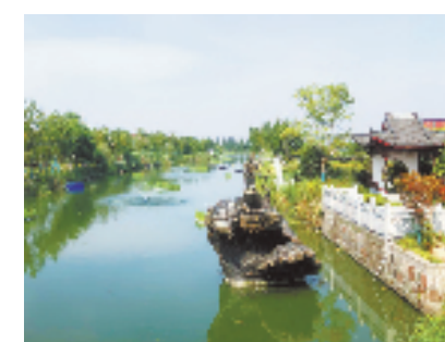
萧东村农污处理终端 钱塘区临江街道供图
