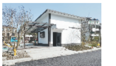
丁山河村农污处理终端 临平区住建局供图
