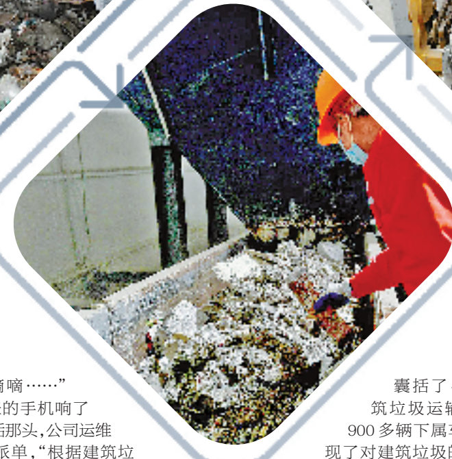
分拣建筑垃圾。
