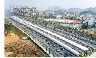
11月2日,杭州中环一运溪路下穿杭徽隧道工程北侧,全长431米的全影型声屏障已基本成型。这种降噪屏障在声源侧面和顶部都设置透明阻声材料,不仅对道路周边底层房屋有减噪效果,对6层以上高层建筑同样有减噪能力。 本报记者 林云龙 摄
