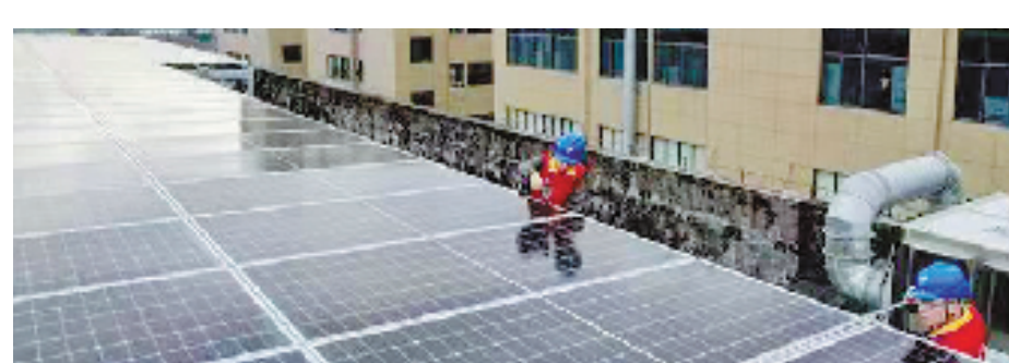
电力工人安装光伏面板 陈辰洲 摄
