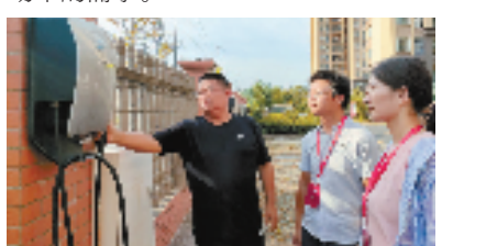
平湖市新能源汽车充电专项治理工作督查组实地察看小区地面车位充电桩电缆铺设情况 彭建伟 摄
