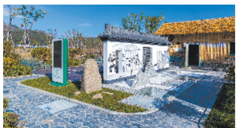
双浦镇湖埠村农污处理设施 (图片由西湖区住建局、双浦镇人民政府提供)
