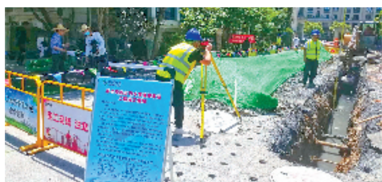
2021年闲林街道“污水零直排”建设项目一期——天和华丰苑改造项目,图为现场施工人员在测量标高,准备铺设管道。
