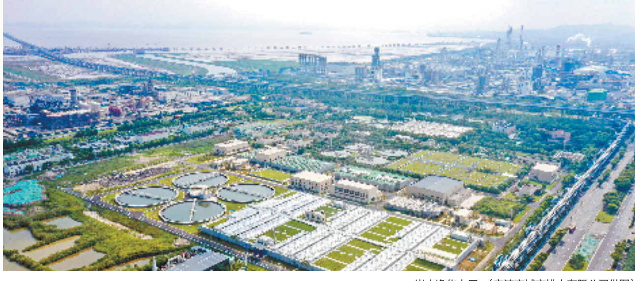
岚山净化水厂（宁波市城市排水有限公司供图）
