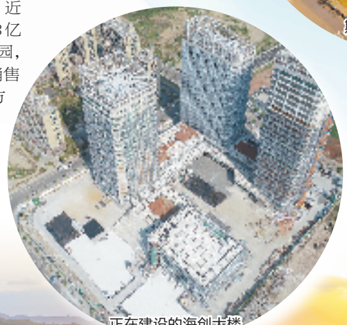
正在建设的海创大楼
