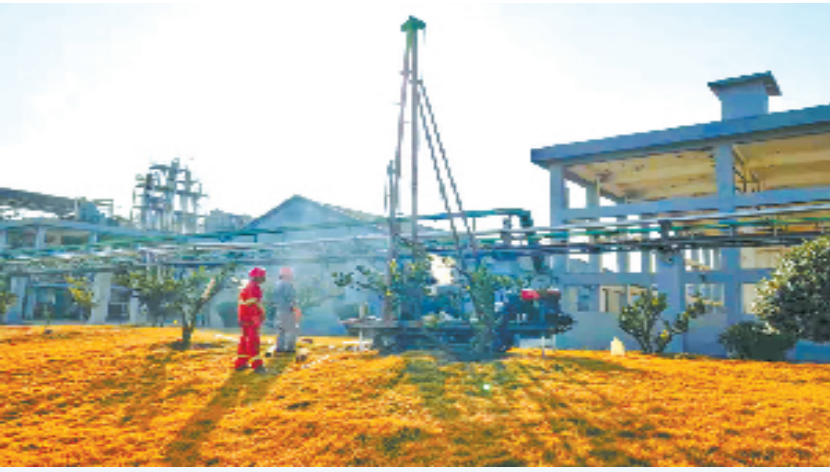
土壤(地下水)污染状况调查打井取样
