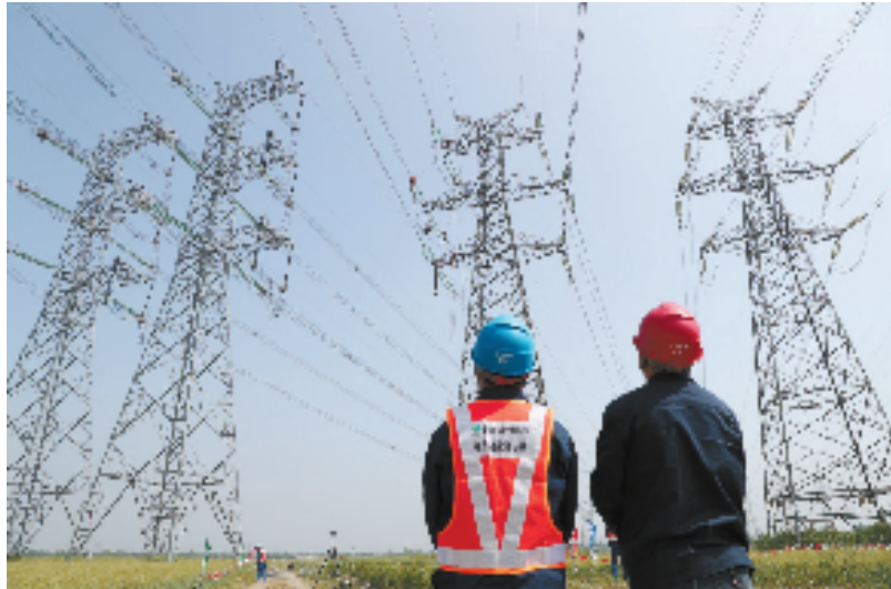
220千伏线路增容改造工程助力杭城电网安全稳定运行
