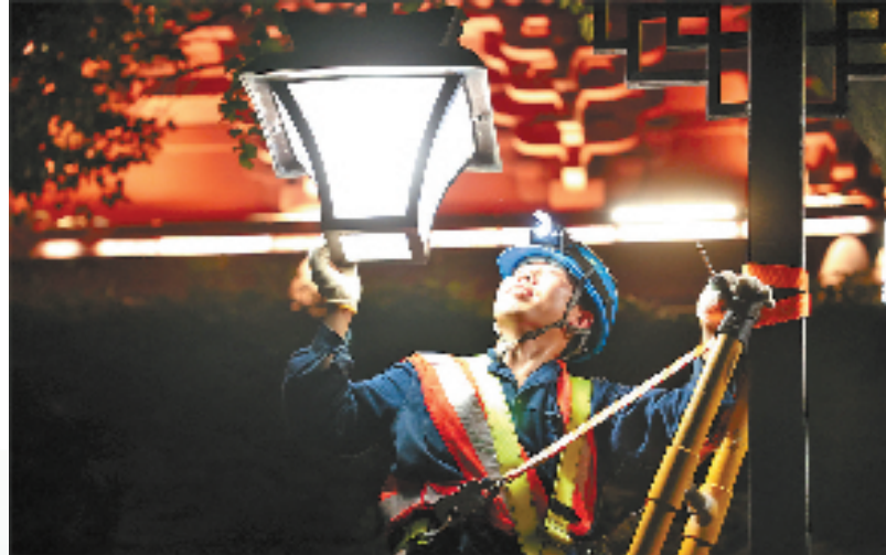
路灯巡检消缺工作保障景区夜间照明
