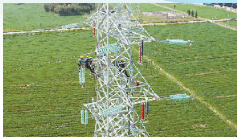
110千伏线路移位助力杭州亚运重要工程项目建设
