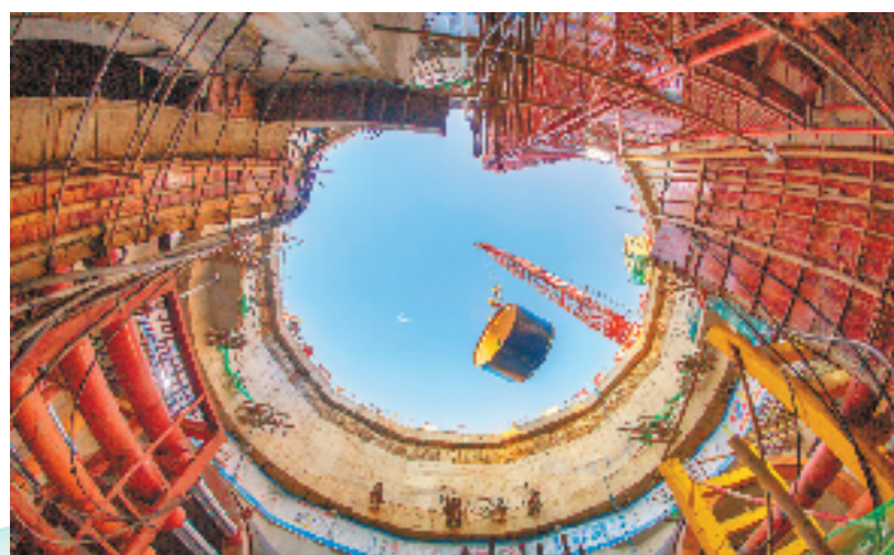
紫金港科技城220千伏架空线上改下隧道工程现场正在敷设国内最长单段电缆
