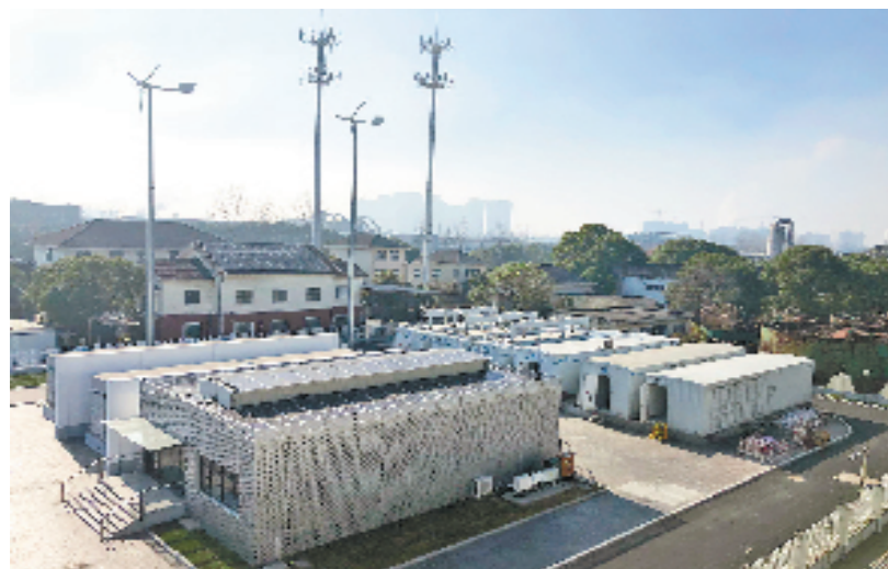
钱塘多能互补零碳柔直示范园的“长风”风光储能电站将清洁电能送到千家万户
