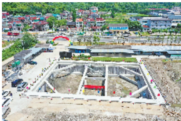
井头山遗址二期发掘用的钢筋水泥框架结构基坑 拍友 陈结生 摄
