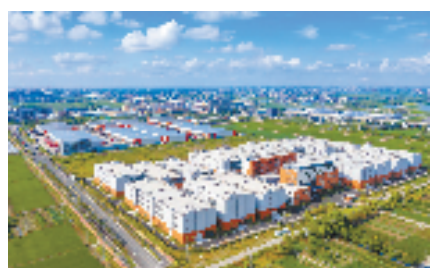
易津新能源汽车产业园
