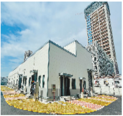
万松110千伏变电站 陈海卯 摄
