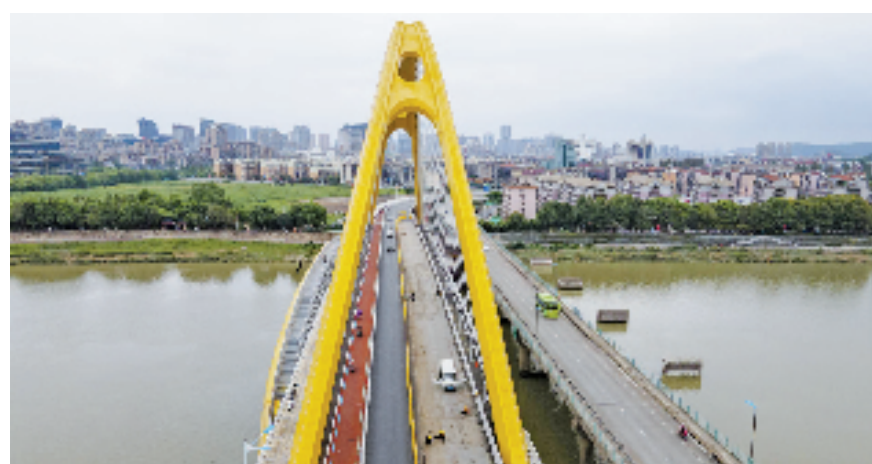
9月21日,工人正在上虞区舜江大桥新桥上翻修路面。 本报记者 吕之遥 摄
