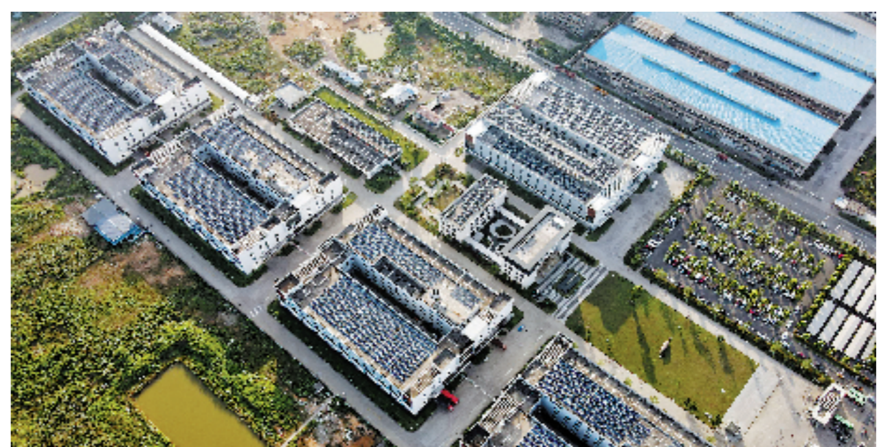
浙江健盛集团江山针织有限公司屋顶上的光伏发电板。
