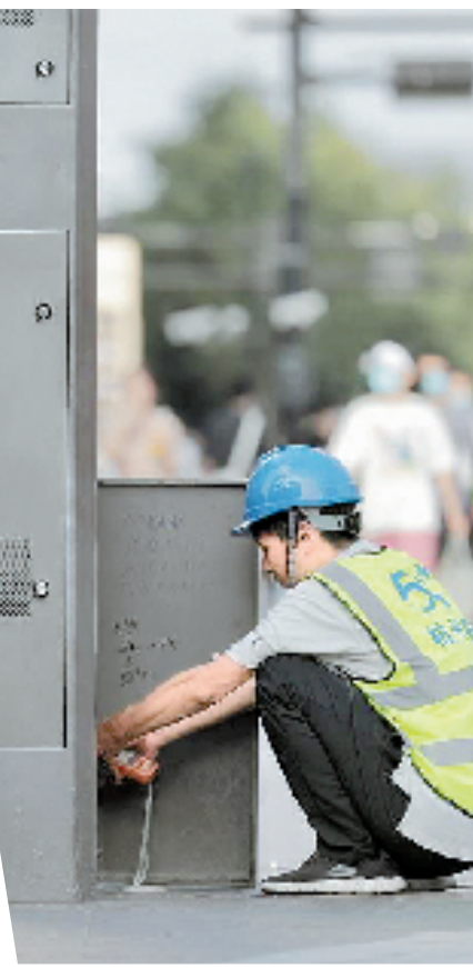
陈海燕在湖滨步行街检修无线通信基站。
