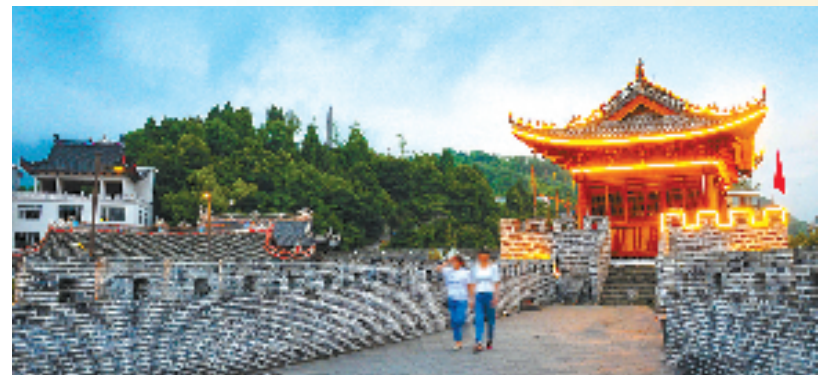
三门县亭旁镇海防署古城墙
