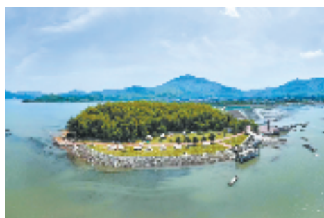
象山县墙头镇新建的露营基地
