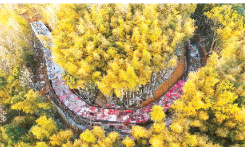
施工中的长岗山段箱涵
