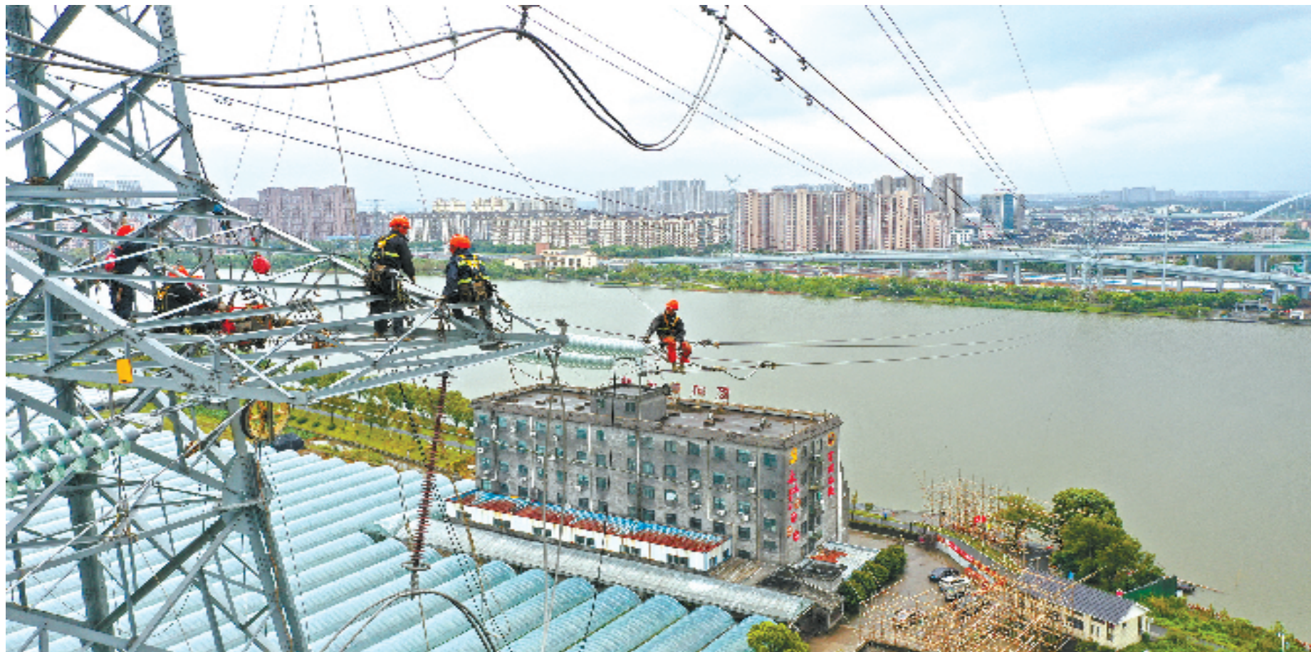
国网宁波供电公司工作人员对新架设220千伏姚西线进行固定安装。王幕宾 摄
