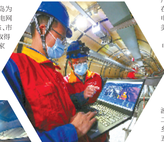
国网宁波供电公司电缆运检人员在220千伏澄浪隧道检查电缆运行状况。王幕宾 摄
